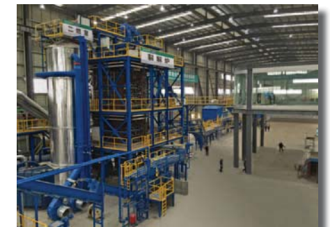
Pyrolyseofen während der Montage
