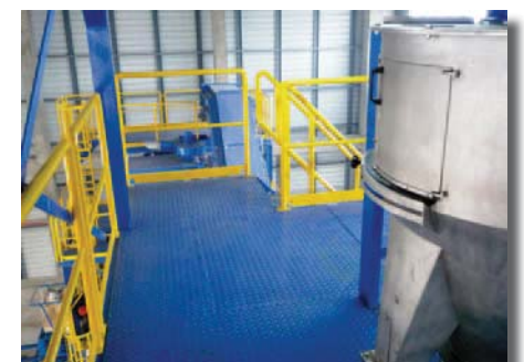
Drehrohrteiler auf Probenahmeturm
